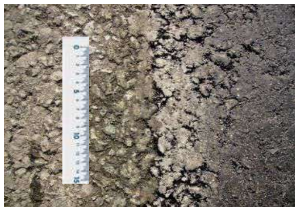
写真-6 縦ジョイント部
