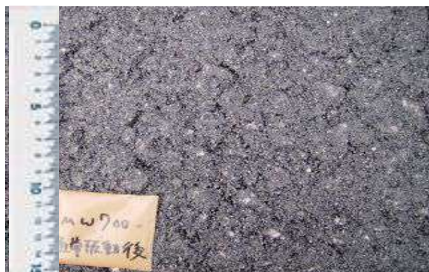
写真-4 初期転圧後の路面
