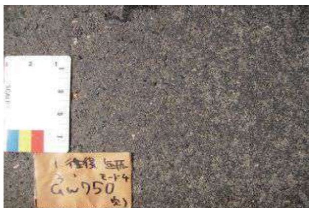
写真-5 二次転圧後の路面
