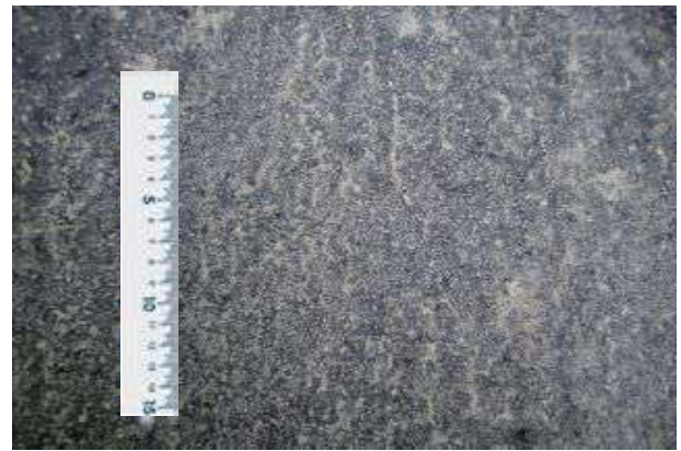
写真-3 3工区での路面状態
