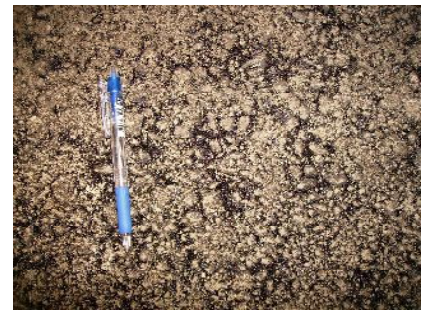
写真-4 二次転圧後 (振動タイヤ)
