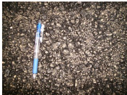
写真-3 初期転圧後 (マカダム)
