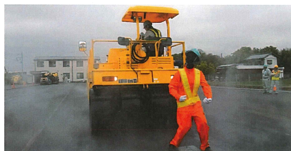
写真-1 実際の試験施工
