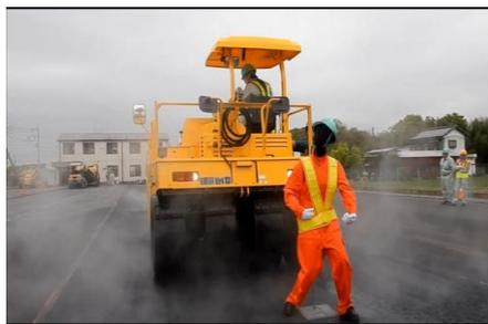
写真-1 舗装現場で発生する湯気
