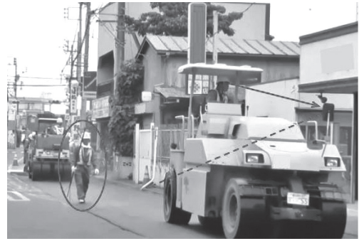
写真-2 タイヤローラ後進時の現場状況
