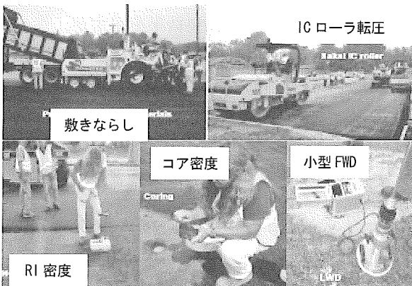
写真-1 試験施工と管理機器による測定
