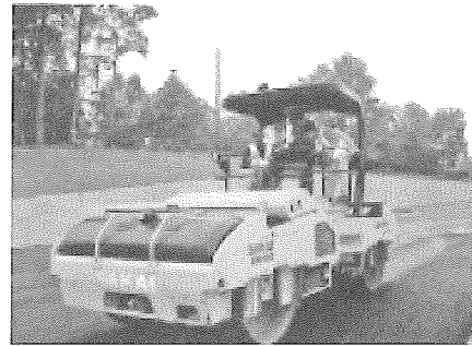
写真一4 ジョージア州試験施工状況
