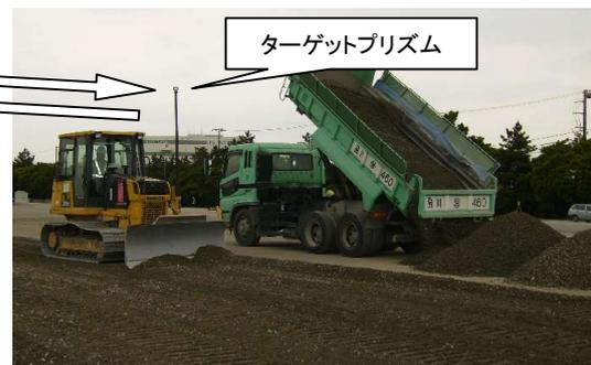
写真 2 3D-MC 付ブルドーザ(コマツ製:D31PX 型)での敷きならし状況
