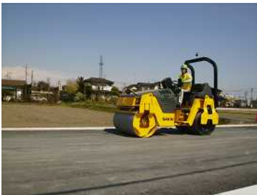
写真-3 CISによるCCV測定状況
