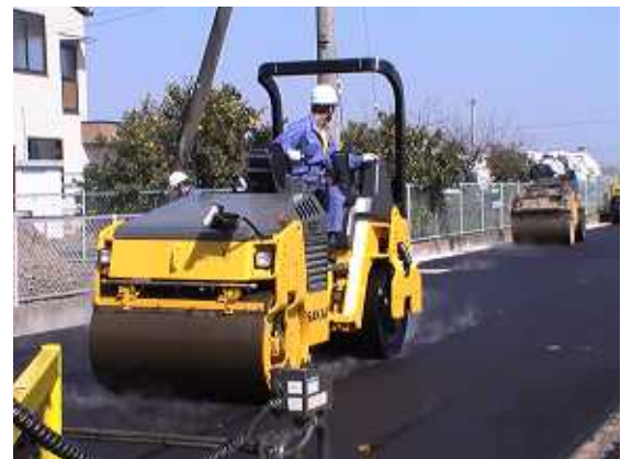
写真-4 初期転圧状況
