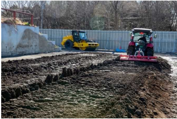
写真-2 盛土と耕運機による攪拌状況
