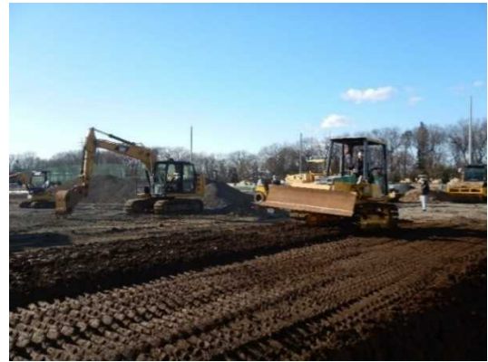
写真-3 ブルドーザによる6回転圧
