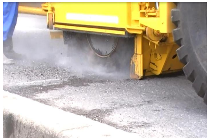
撮影時のホイール式路面切削機 ER552F の作業風景
