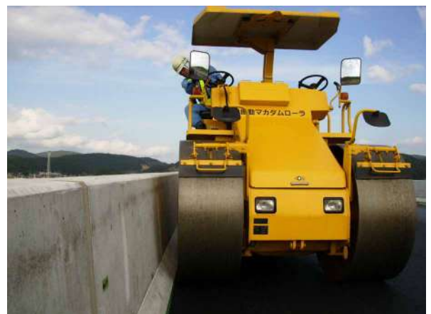
図2 橋梁部施工状況
