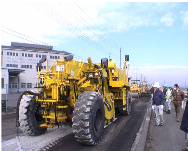
写真 PM550 による攪拌・混合状況
