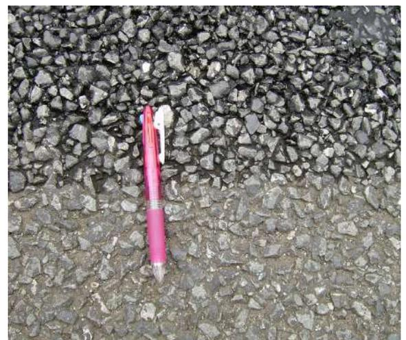
写真 洗浄後の路面（上が洗浄後、下が洗浄前）
