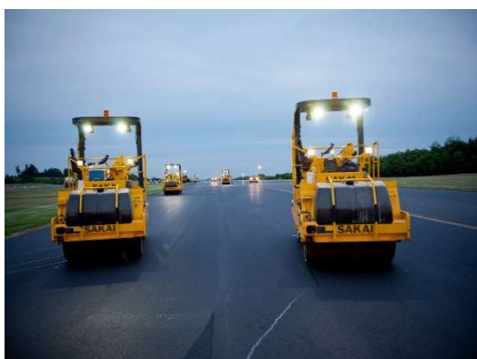
米国の高速道路舗装工事
