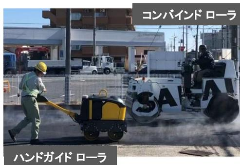
実際の施工現場にて、電動コンバインドローラおよび電動ハンドガイドローラの実証実験を実施。電動ハンドガイドローラは今年度中に販売開始予定。国交省が認定する「GX建機」(環境省の補助金対象)の来期認定取得を目指す。
