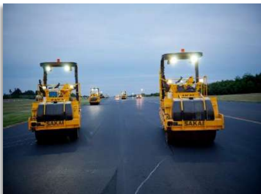
米国の高速道路舗装工事
