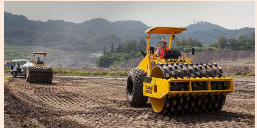
大型土工用振動ローラ
